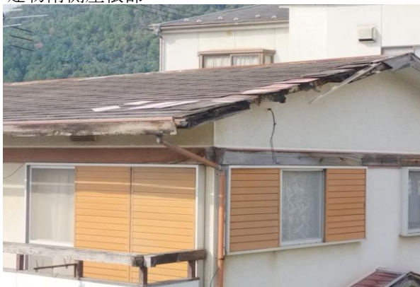
建物南側屋根部
