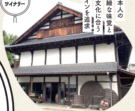
古民家 再生現場
