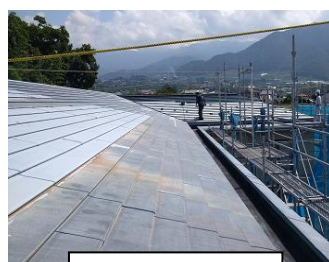
古い塗装の除去
