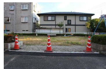
工事中の出入り口部分
